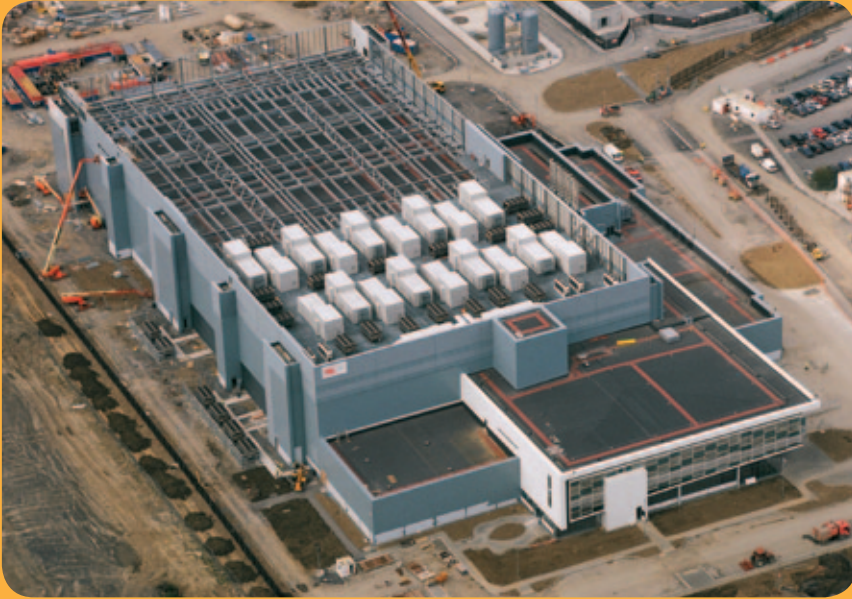
Figuur 3 modern datacenter in aanbouw © 2009 Microsoft Data Center in Dublin
